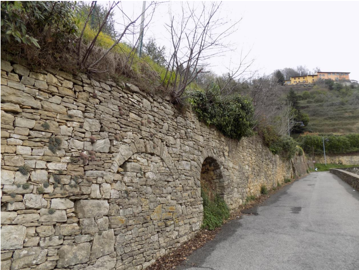
Muri di sostegno in via Torni a Bergamo
